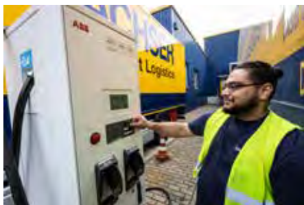
Stromtankstellen gehören zur notwendigen Infrastruktur für eine E-Wagenflotte.
