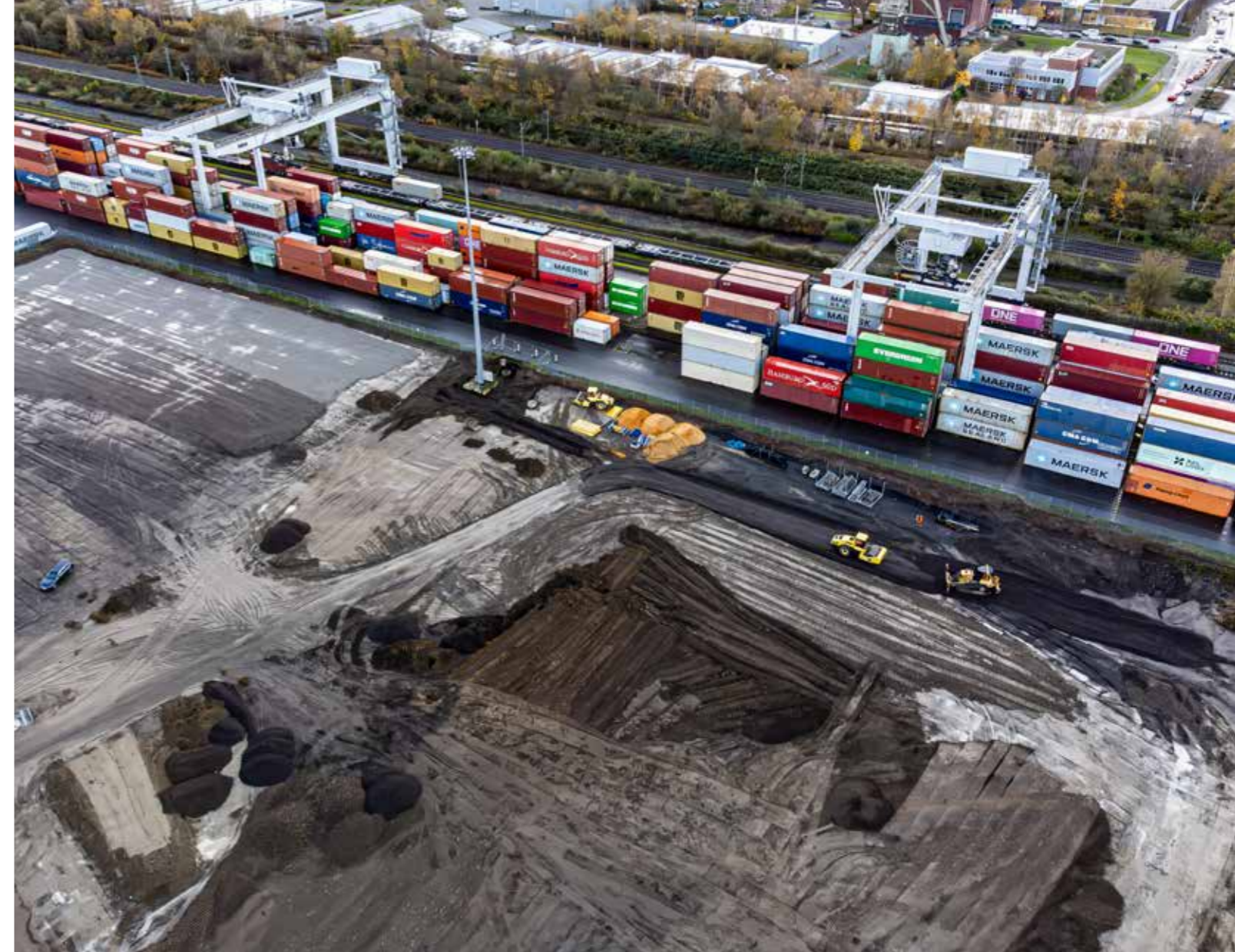
Moderne Logistik: Die KV-Anlage an der Franz-Schlüter-Straße im Hafen verfügt über Anschluss an Straße und Schiene.
