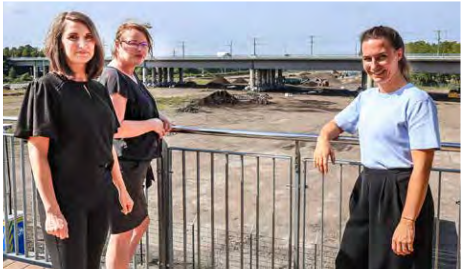
Die DB-Mitarbeiterinnen Anne Stephan, Cindy Hilbert und Maria Otte (v.l.) vor der Baustelle an der Westfaliastraße.
