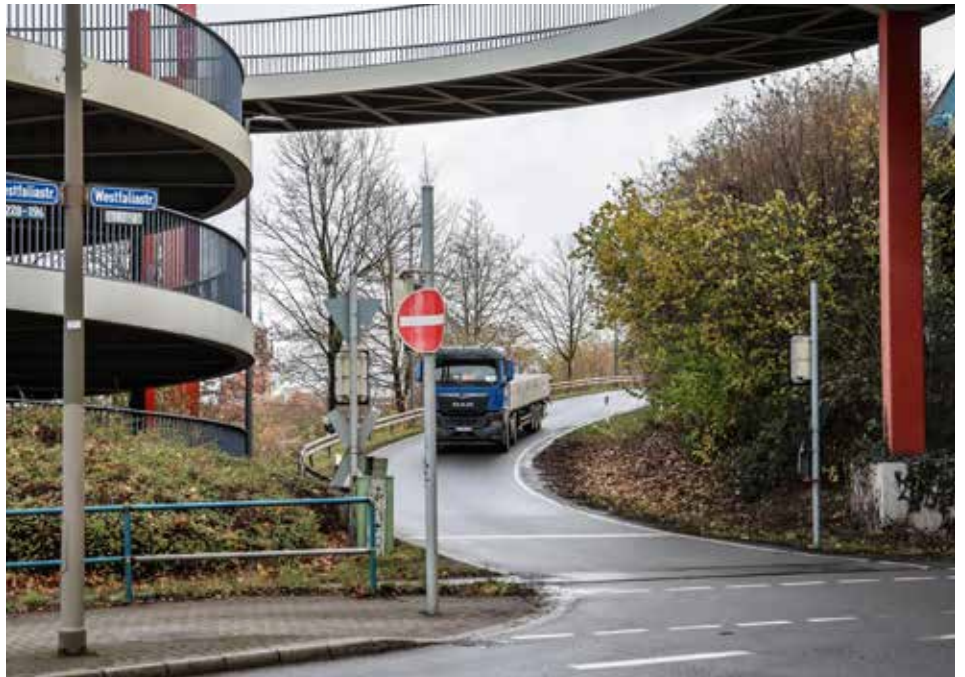
Der Umweg, den Lkw aus Richtung Westen kommend, zum Gewerbegebiet Westfalia fahren müssen, soll bald der Vergangenheit angehören.
