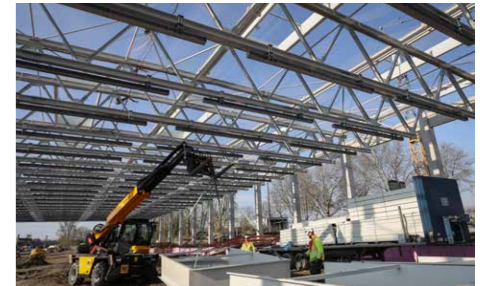
Die Arbeiten auf Dortmunds wohl größter Baustelle liegen im Zeitplan.
