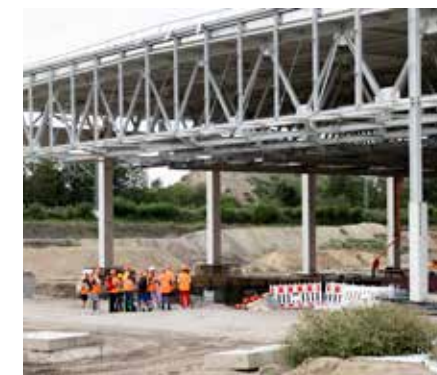
Notfalls wird auf der Baustelle sogar sonntags gearbeitet.
